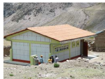
I.E. N° 22572 DE CAVITUNA
