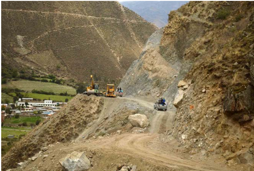
Construcción Carretera Cocas - Chivincuri
